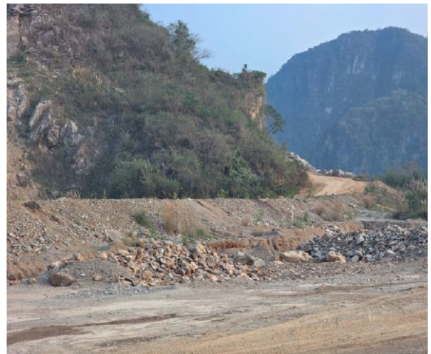
รูปที่ 2-34 (ต่อ) คั่นดักหินขนาดความกว้าง ประมาณ 10 ม. สูง ประมาณ 5 ม.
