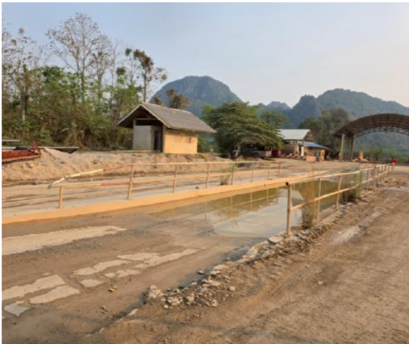
รูปที่ 2-23 จุดล้างล้อรถบรรทุกก่อนนอกโครงการ
