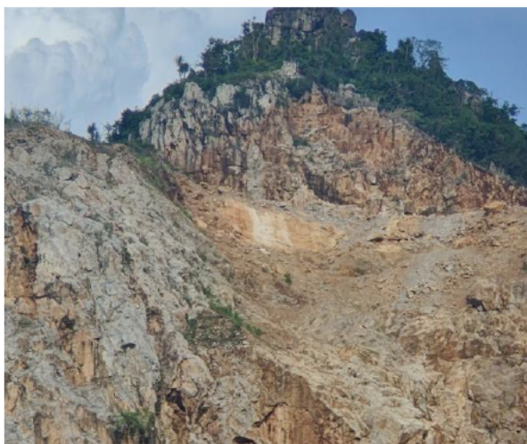
รูปที่ 2-19 การปรับแต่งผนังบ่อเหมืองให้เป็นขั้นบันได
